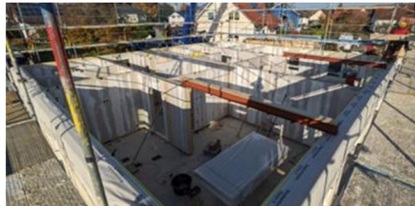
**Abbildung 24:** Montage des Erdgeschosses des Bauvorhabens 84207 [77]
