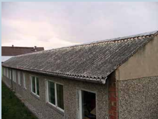
Bild 2 Dachdeckung aus Wellasbestzement [C.1]
