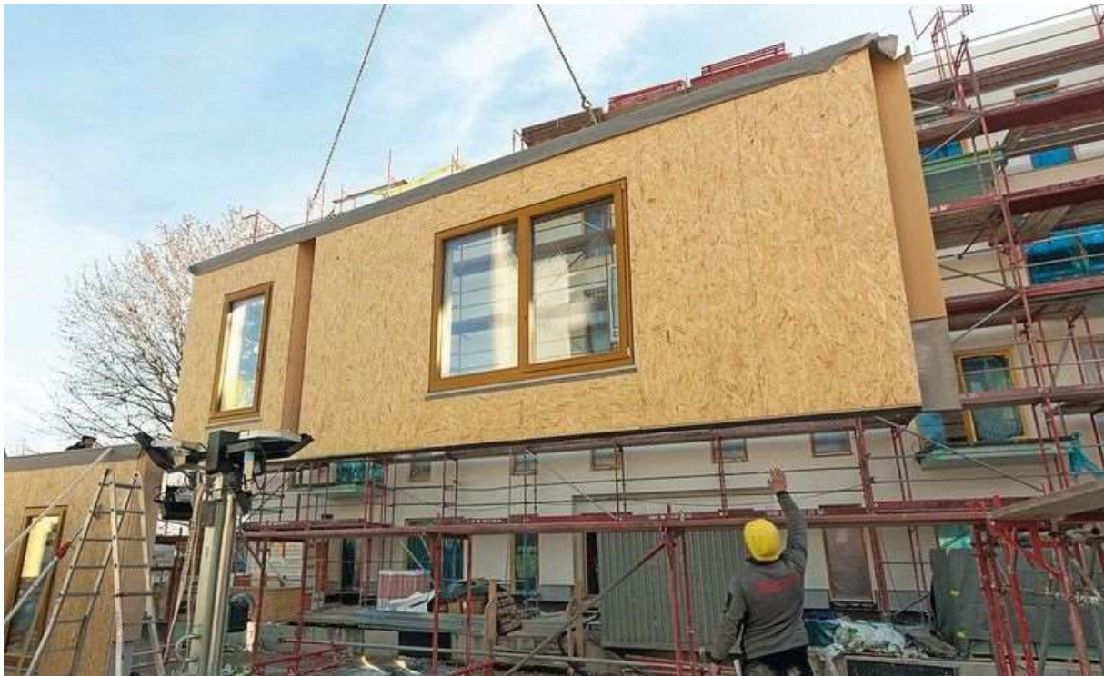
Abbildung 14: Montage von Holztafelbauwänden
