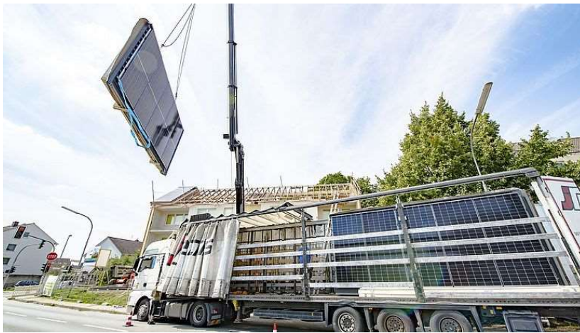
Abbildung 1919: Montage von Dachmodulen mit integrierter Photovoltaik
