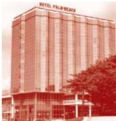
Ein Hotelbau in Lome-Togo: vollklimatisiertes Glasgebäude mit hohem Kühlenergieaufwand durch Nichtbeachtung des tropischen Küstenklimas, Breitseiten geöffnet nach Osten und Westen mit extremer solarer Aufheizung
