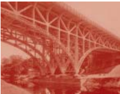
Abb. 10: Die Stößenseebrücke in Berlin, Karl Bernhard, 1909
