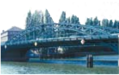
Abb. 7: Stubenrauchbrücke in Berlin-Oberschöneweide, Karl Bernhard, 1908
