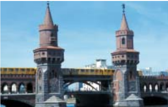
Abb. 4: Die Oberbaumbrücke in Berlin
