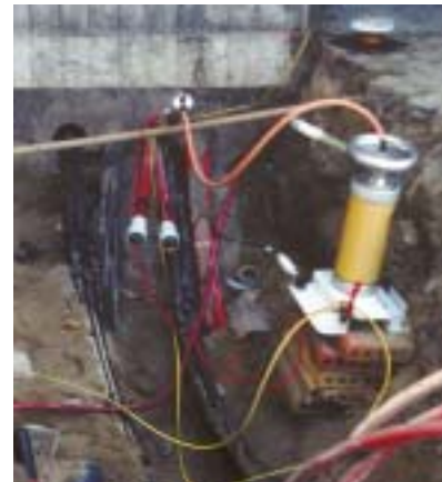
Abb. 5: Teilentladungsmessung vor Ort
