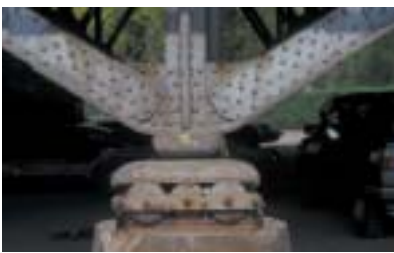
Abb. 9: Gleitlager der Freybrücke
